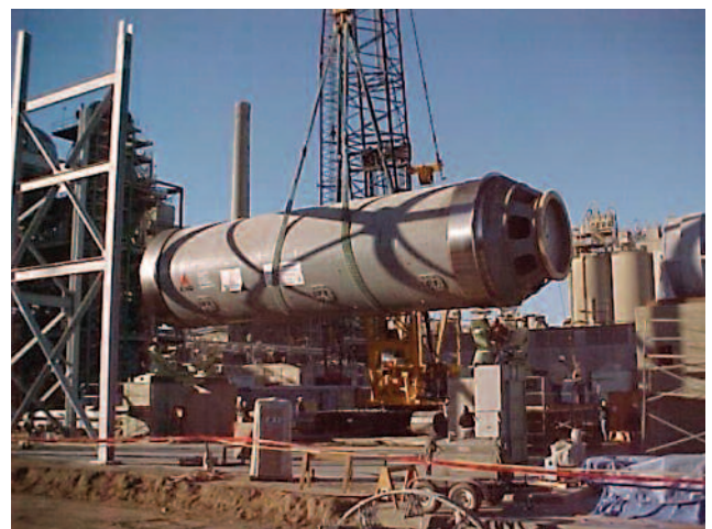
Remise à neuf d'un four à ciment de 220 tonnes accompli avec Twin-Path MD
